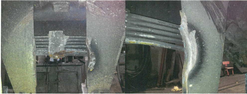
Abbildung 2-3: Beschädigungen am Radsatzhalter des Unfallfahrzeugs
